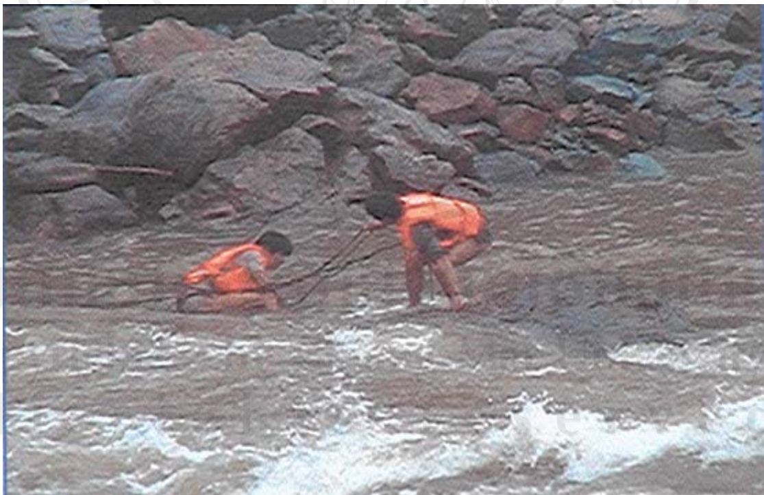
ภาพ 10 แสดงการใช้แรงงานคนในการวางระเบิดกรณีเรือปฏิบัติการไม่สามารถเข้าถึงได้ บริเวณแก่งตั้งชาลัม
