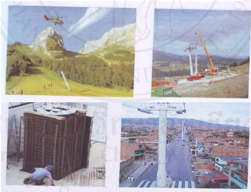
ภาพ 11 ลักษณะตัวอย่างการก่อสร้างเสารับสายเคเบิล
