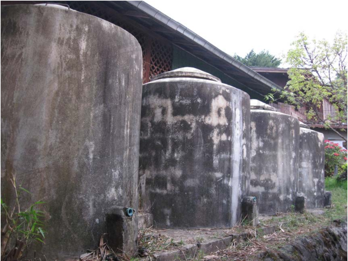
ภาพที่ 6 บ่อพักน้ำฝนที่ทางโรงเรียนศรีเนห์รูมีไว้สำหรับกักเก็บน้ำในยามจำเป็น
