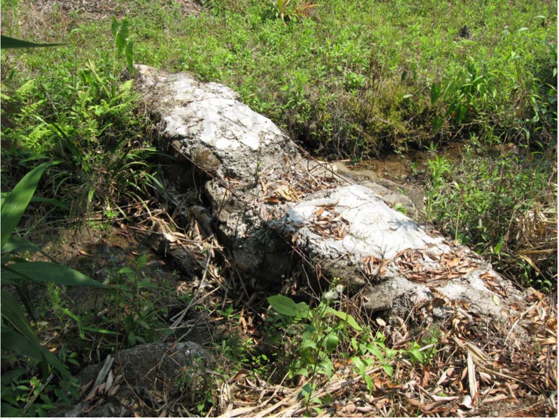
ภาพที่ 9 ฝ่ายต้นน้ำอีกชนิดหนึ่งที่ทำด้วยหิน ซึ่งเป็นวัสดุอุปกรณ์ที่หาได้ง่ายในบริเวณนั้น
