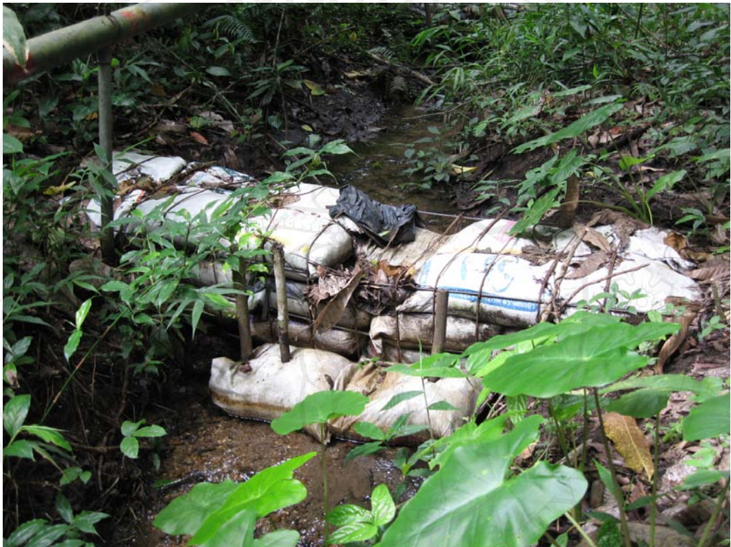
ภาพที่ 3 ลักษณะของฝายต้นน้ำแบบผสมผสานที่ชาวบ้านหมู่บ้านขุนช้างเคียนร่วมกันสร้างในแต่ ละพื้นที่
