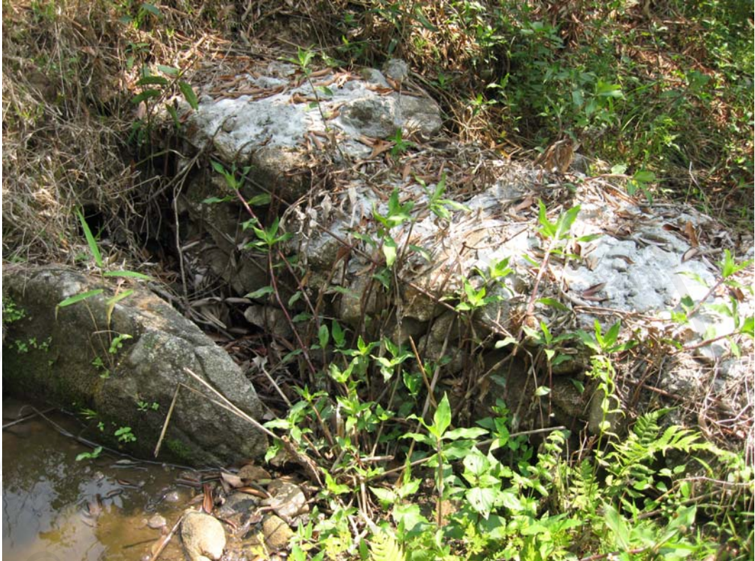
ภาพที่ 4 ลักษณะของฝายหินก่อที่ชาวบ้านหมู่บ้านขุนช้างเคียงร่วมกันสร้าง
