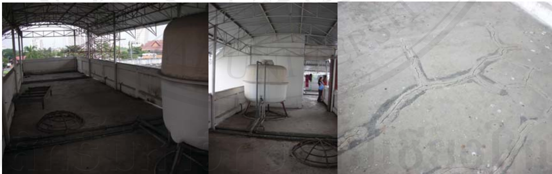
ภาพ 5 -4 5-5 และ 5-6 สภาพภายในบริเวณชั้นคาดฟ้าอาคารล้านนา 1
