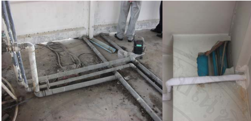
ภาพ 5 – 31 และ 5-32 สภาพงานระบบประปาของอาคารล้านนา 1
