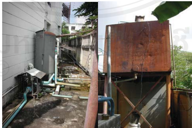
ภาพ 5-29 และ 5-30 สภาพถังอัด และถังเก็บน้ำประปาของอาคารล้านนา 1
