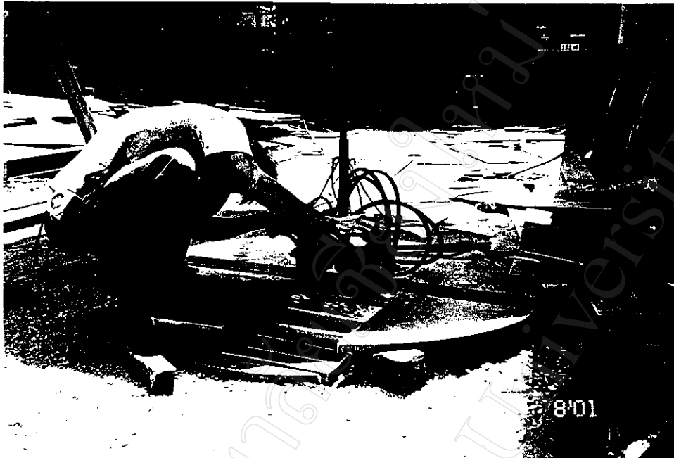
ภาพที่ 18 การตัดเหล็กก่อนนำไปขึ้นรูป
