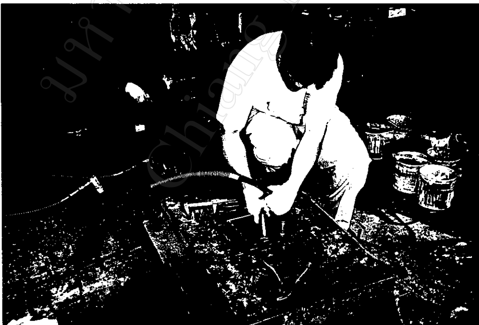
ภาพที่ 38 การอัดเสาแบบให้แน่น
