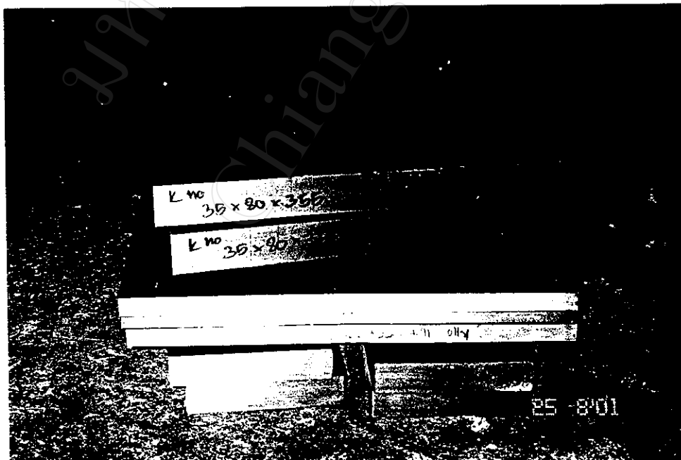
ภาพที่ 25 ชิ้นส่วนของฝาแบบที่พร้อมจะนำไปใช้งาน
