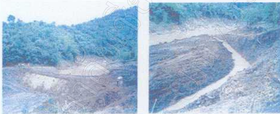
รูปที่ 27 สภาพการก่อสร้างฝายชั่วคราวในลำห้วยน้ำก้อ และการขุดลอกชักน้ำบริเวณหน้าฝาย
