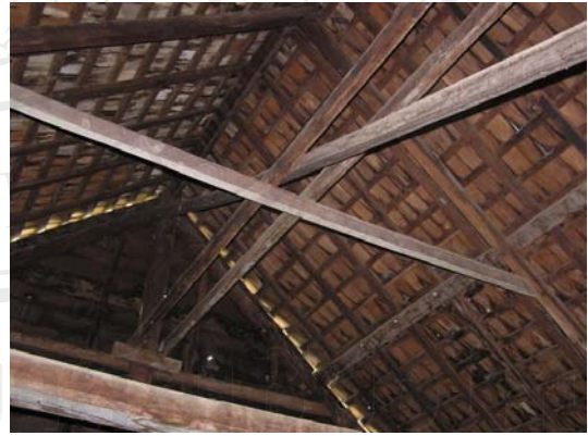
ภาพที่ 2.26 ภาพโครงสร้างหลังคาเรือนไทลื้อ
