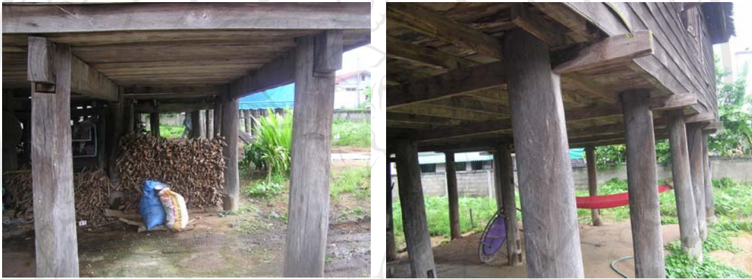
ภาพที่ 2.24 ภาพโครงสร้างพื้นเรือนไทลื้อ
