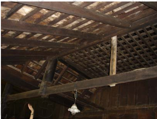
ภาพที่ 2.26 ภาพโครงสร้างหลังคาเรือนไทลื้อ
