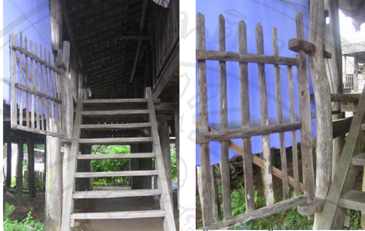
ภาพที่ 2.28 ภาพบันไดทางขึ้นเรือนไทลื้อและประตูแอ้ว
