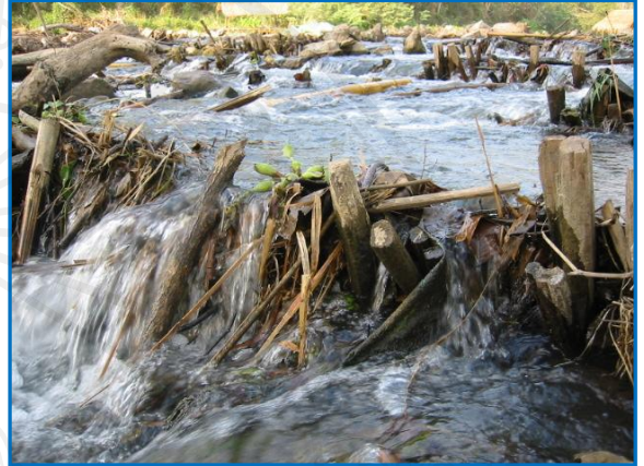
ภาพ 4.15 ไม้หลัก วัสดุที่ใช้สร้างฝายในอดีต
