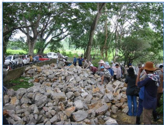
ภาพ 4.17 หินที่นำไปบรรจุในก่อก่ออิฐหิน วัสดุที่ใช้สร้างฝายในปัจจุบัน
