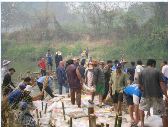
ภาพ 4.20 การนำกระสอบทรายวางทับชั้นกล่องหิน
