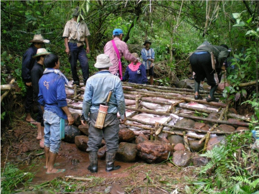
ภาพ 4.8 ชาวบ้านร่วมกันสร้างฝายขนาดเล็กในบริเวณป่าชุมชน
