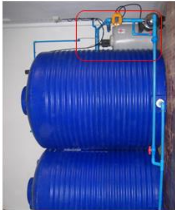
ภาพประกอบ 6: แสดงชุดอุปกรณ์ทดสอบระบบ Reverse Osmosis และ ชุดกรองน้ำดื่ม
