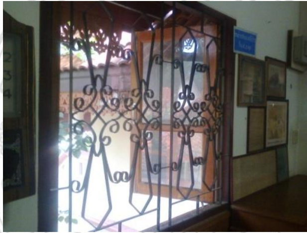
ภาพที่ 4.44 การติดตั้งเหล็กดัดช่องหน้าต่างในอาคารพิพิธภัณฑ์สถานเขลางคนคร
