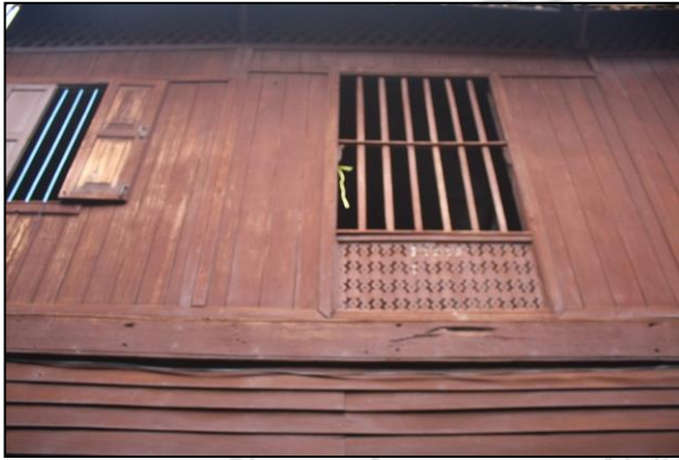
ภาพที่ 5.7 ฝาบ้าน ประตู ทำจากไม้พื้นถื่นไม้แดง ไม้สัก
