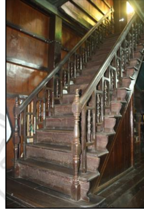
ภาพที่ 5.16 บันได และราวบันไดขึ้น-ลงชั้นล่าง-บน
