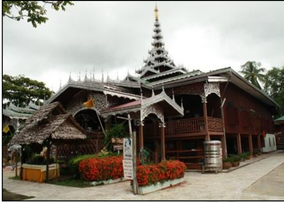
ภาพที่ 5.86 ศาลาการเปรียญ แบบไทใหญ่ยกพื้น หลังคาทรงปราสาท 9 ชั้น ประดับยอดด้วยฉัตร
