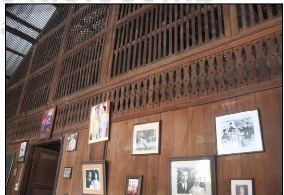
ภาพที่ 5.24 ช่องลมไม้ และฝ้ายบ้าน บริเวณมุขหน้าชั้น 2
