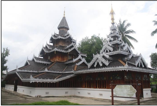
ภาพที่ 5.74 วิหารพลาละแข่ง ทรงปราสาทหลังคาซ้อนชั้น หลังคามุงด้วยเป็นเกล็ดไม้ ปลายยอดประดับด้วยโคม ไม้กลิ้ง
