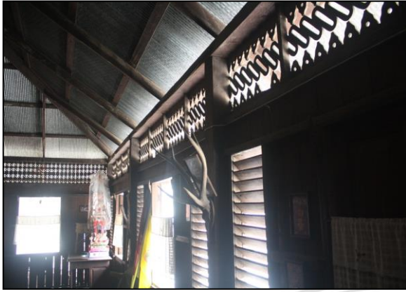
ภาพที่ 5.25 ช่องลมไม้ ลวดลายต่างๆ และหน้าต่างไม้บานเกล็ด
