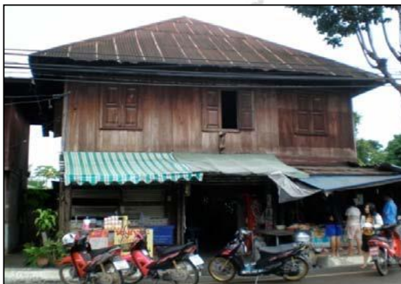
ภาพที่ 5.44 ทรงหลังคา และ โครงสร้างส่วนหน้า
