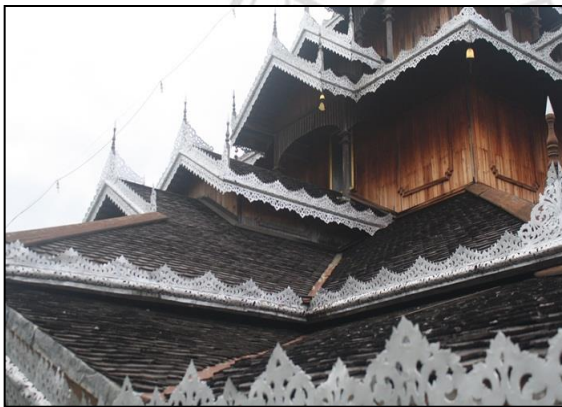
ภาพที่ 5.76 หลังคาวิหารพลาละแข่ง แบบซ้อนชั้น มุงด้วย เป็นเกล็ดไม้ ประดับด้วยสังกะสีฉลุลาย
