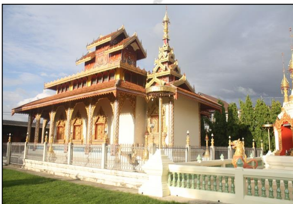
ภาพที่ 5.78 อุโบสถประยุกต์แบบก่ออิฐถือปูน หลังคา ซ้อนชั้นแบบไทใหญ่ รูปทรง
