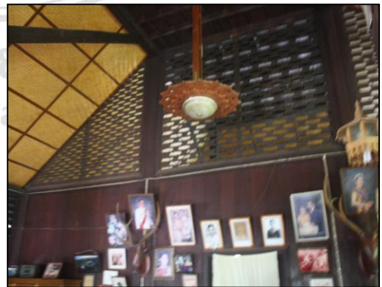
ภาพที่ 5.32 ฝาบ้าน ช่อลมไม้สัก และโครงสร้างใต้ หลังคา
