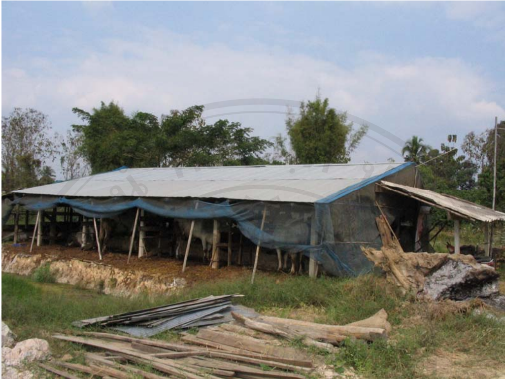
ภาพที่ 3 หลังคาโรงเรียนโคขุนที่มุงด้วยสังกะสี
