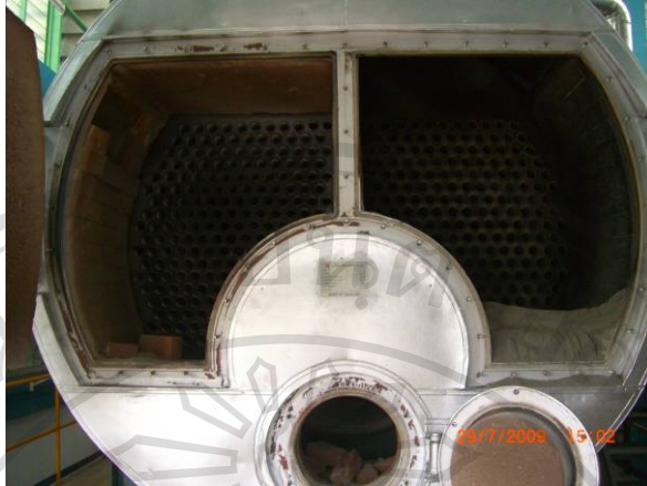
รูปที่ 4.10 หม้อไอน้ำแบบท่อไฟที่มีน้ำอยู่ล้อมรอบ ที่มา: จากการศึกษา, 2552
