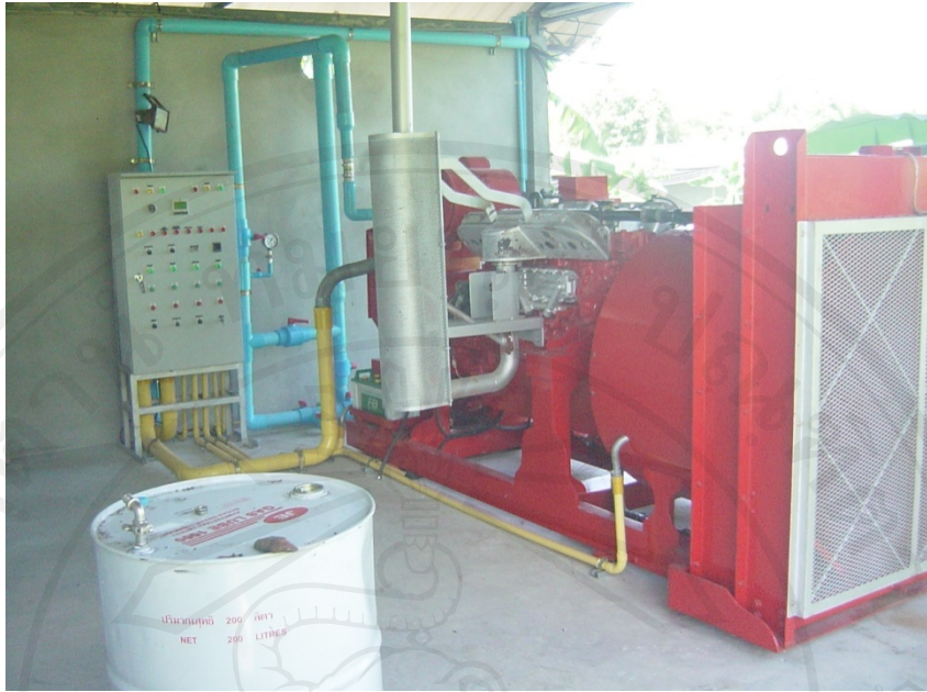
รูปที่ ข.5 ภาพถ่ายเครื่องผลิตไฟฟ้าจากระบบไบโอแก๊สของ ช.ฟาร์ม
