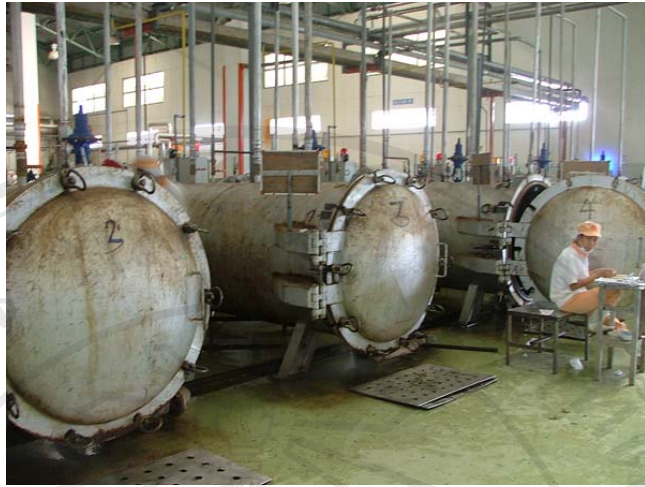
ภาพที่ 4.23 ท่อส่งไอน้ำไปยังหม้อน้ำมาเชื้อก่อนหุ้มฉนวน
