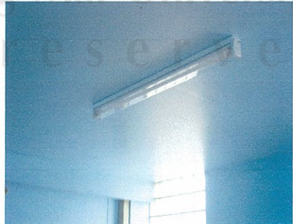
รูปที่ 4.41 ฝ้าเพดานเรียบ หลอดไฟมีฝาครอบ
