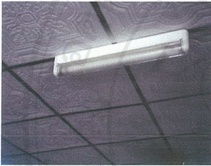
รูปที่ 4.32 เพดานเรียบ มีฝาครอบหลอดไฟ
