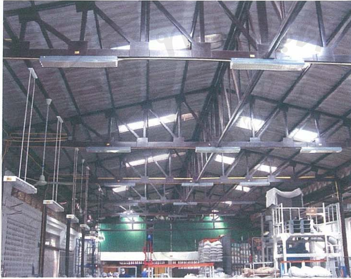
ภาพที่ 4.5 ความสว่างเพียงพอในการผลิต และโหลดไฟมีฝาครอบ
