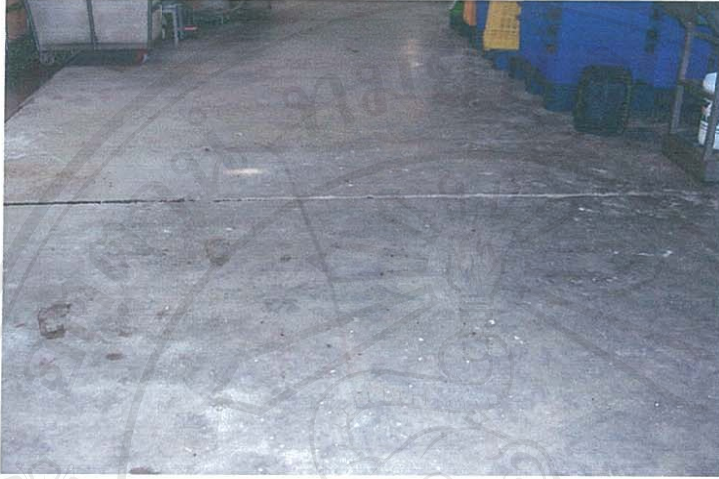
ภาพที่ 4.3 พื้นของอาคารผลิตมีผิวเรียบและลาดเอียง
