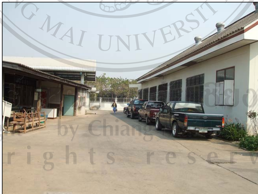
ด้านซ้ายของอาคารผลิต/โรงครัว
